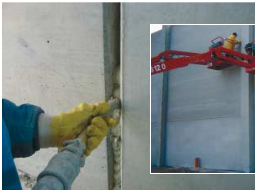
Abb. 1 Fugenverguss ohne Anschalen mit dem Philipp Thixo Mörtel.
